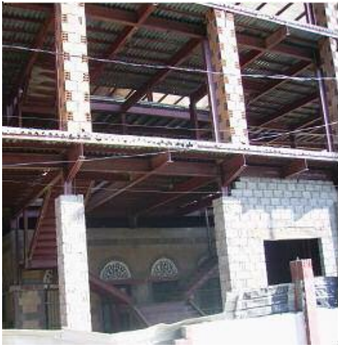
شكل (9) مبنى تجاري حديث قيد الإنشاء ويلاحظ المبنى القديم بداخله مازال قائماً - إحدى طرق إعادة استثمار الأرض المكان: شارع حده تقاطع شارع جبوتي
